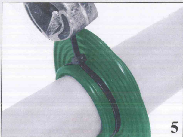
Die Spannbänder können auch mit der Zange angezogen werden
