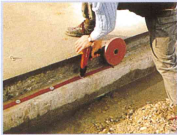
Verlegen von Abdichtungssystemen
