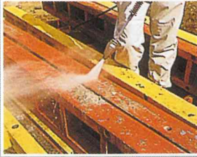
Schalung reinigen
