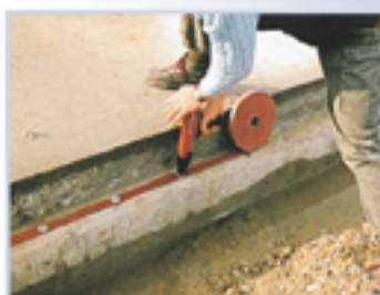
Pose de systèmes d'étanchéité
