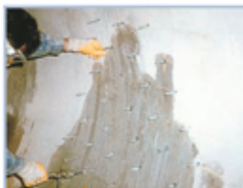
Colmatage des fissures
