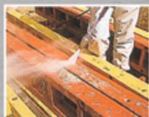
Nettoyage des coffrages
