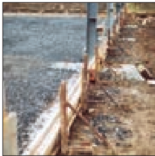
Schalhilfe zur Erstellung von Bodenplatten.
