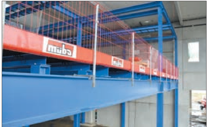
AS- System im Einsatz mit T-Trägerklemmen
