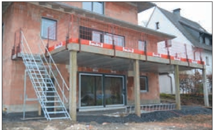
AS- System im Einsatz mit T-Trägerklemmen
