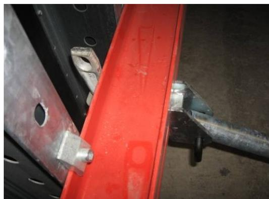
Befestigung des Richtkonsolenanschlusses mit Keil
