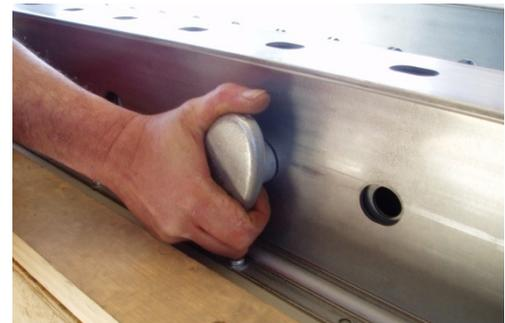
Exzenter drehen, danach Befestigung der Schalhaut
