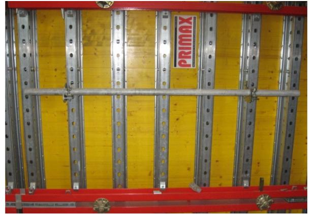
Gerüstrohr an der Schalung befestigt
