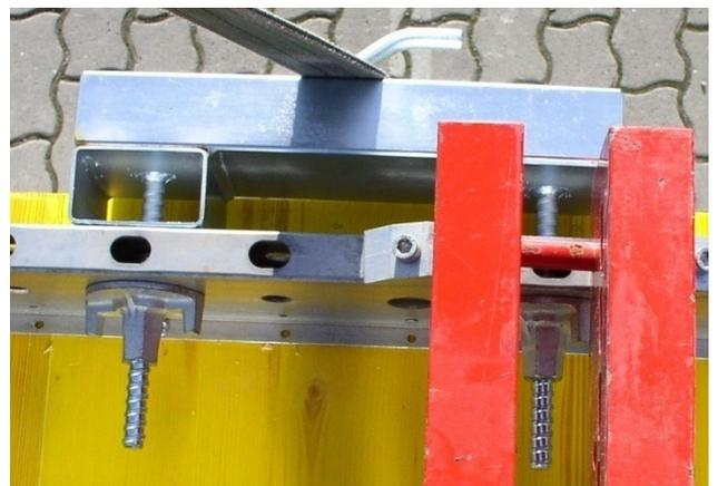
Sicherung der Ladehilfe mit zwei Flanschmuttern
