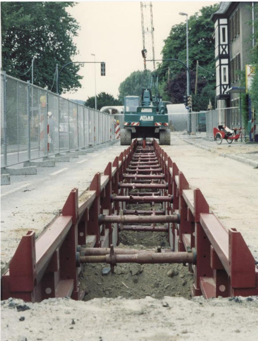
**Das System besteht aus nur 2 Bauteilen: Verbauplatte und Strebe.**
