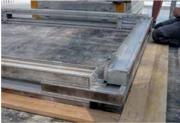
Einfaches Umsetzen der komplett montierten Einheit
