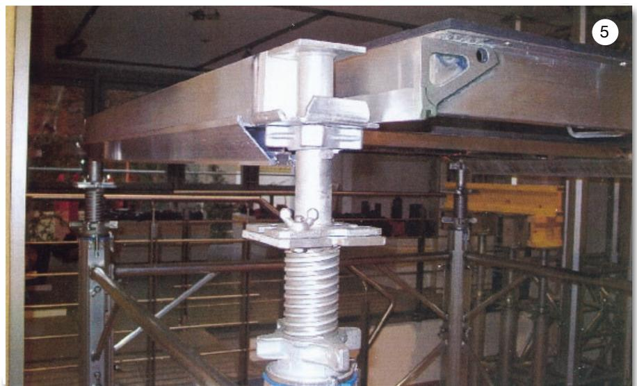
Die massive GFK-Platte 10 mm ist blind verschraubt mit dem Alu-Rahmen zum Alu-Deckenpaneel. Nur noch ein Deckenpaneel (1,7 m x 0,45 m = 0,77 m<sup>2</sup>, Gewicht ca. 16,5 kg) muss verlegt und ausgeschalt werden.
