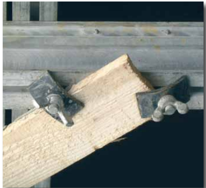
Aussteifung mit Klemmstück und Brett
