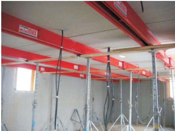
Kombination DT 375 und ET 300 - mittlere Stützweite = **237 cm**
