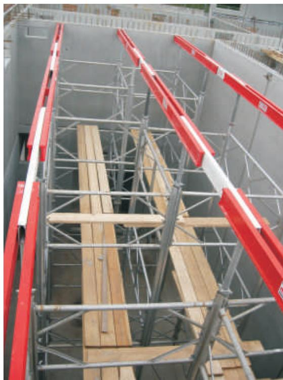
Kombination DT 375 und ET 225 - mittlere Stützweite = **221 cm**
