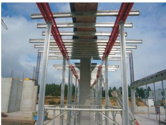
Kombination DT 240 und ET 210 - mittlere Stützweite = **160 cm**
