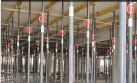
Spindelstützen TITAN HV
