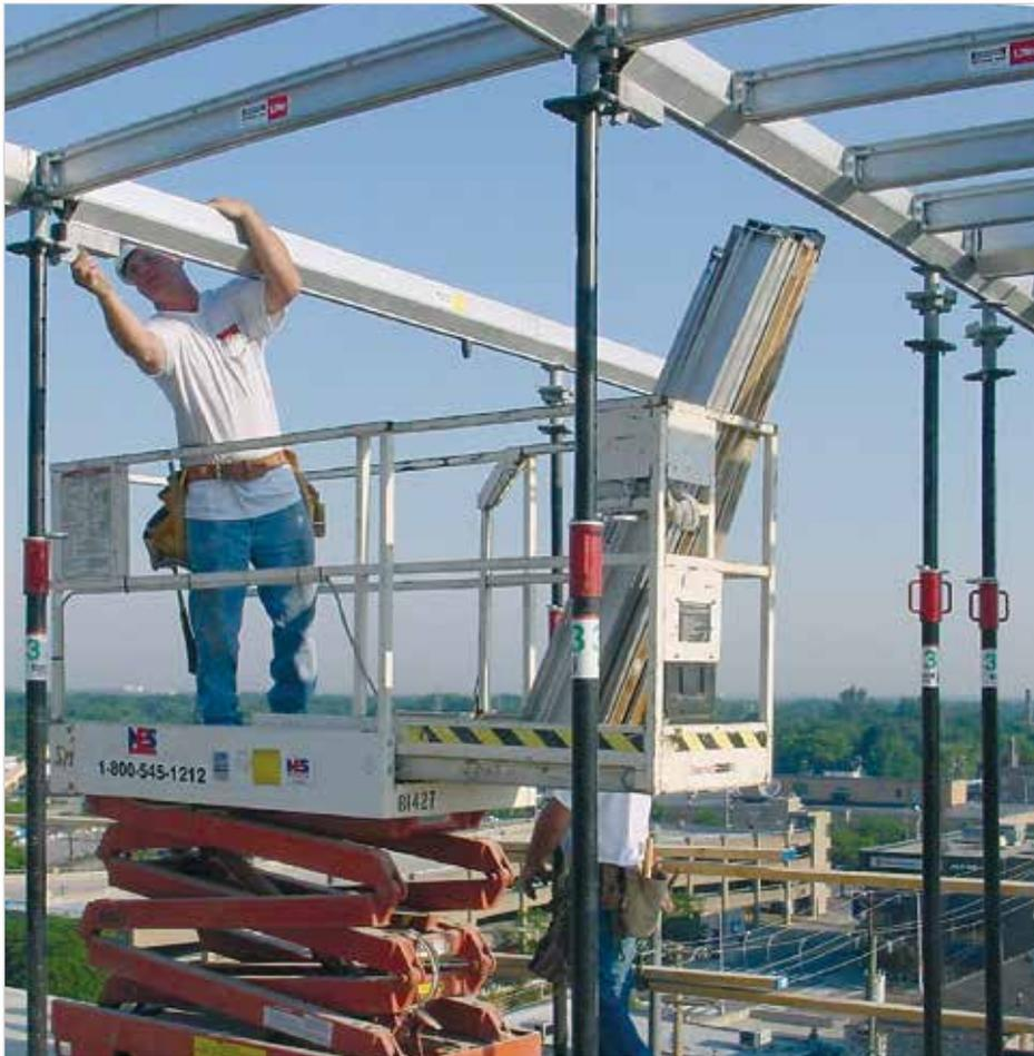
Schalungsstützen TITAN Gr. 3 im Einsatz mit dem Alu-Deckenschalungssystem TITAN HV. Auskragende Randträger werden zusätzlich gesichert.
