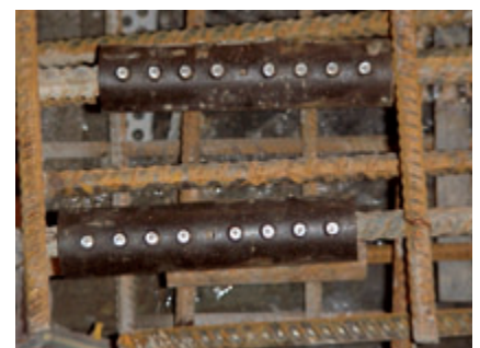
Stoß einer Längsbewehrung mit Standardmuffen
