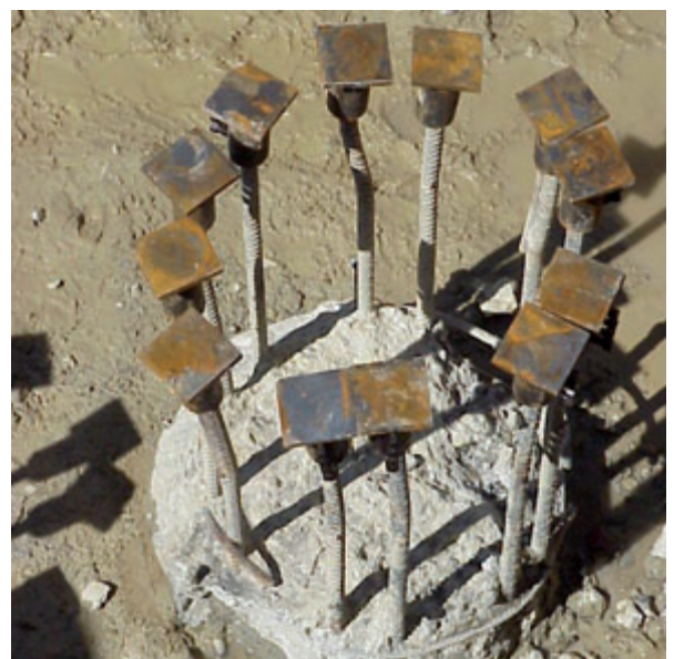
Detail der Endverankerung in einem Bohrpfahl
