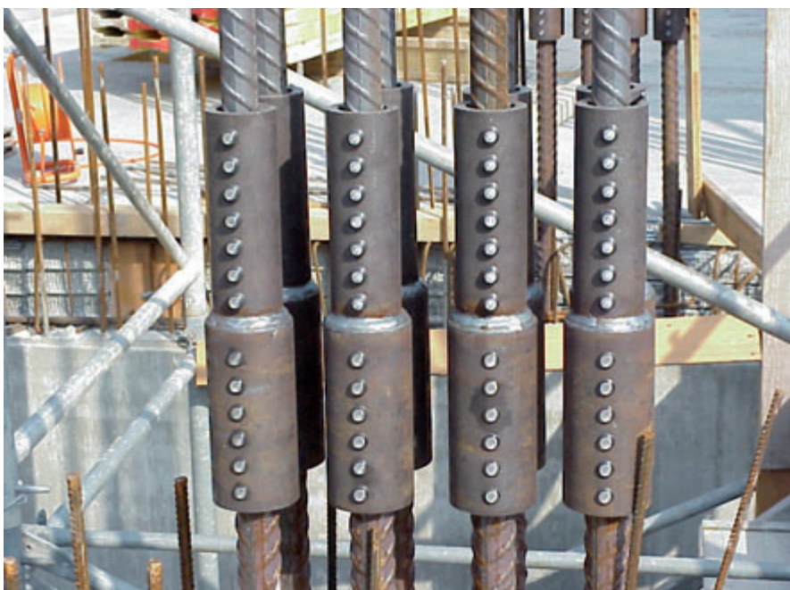
Stützenfuß mit Reduziermuffen
