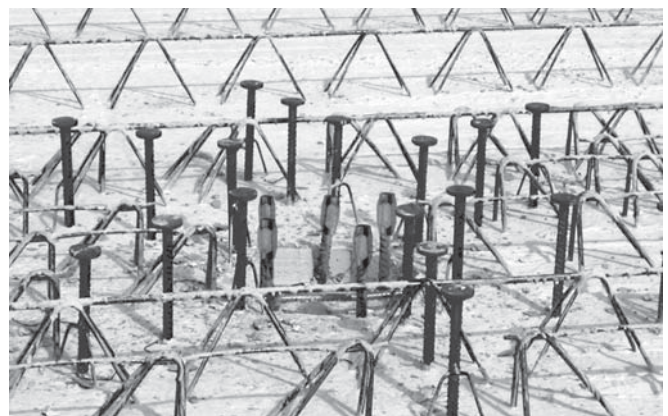
Elementdecke mit Dübelleisten HDB-F auf der Baustelle. Die Montageleisten sind abgenommen, die obere Bewehrung kann behinderungsfrei aufgelegt werden.
