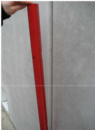
1.) Anlegen der Ruck-Zuck Schiene an der abzudichtenden Stoßfuge
