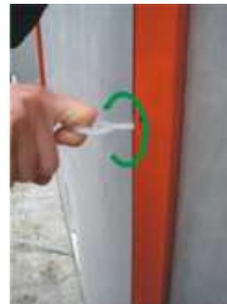
4.) Die Demontage erfolgt durch überdrehen des Ruck-Zuck Ankers
