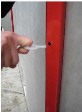
3.) Drehen & Ziehen des Ruck-Zuck Ankers zur Arretierung der Ruck-Zuck Schiene
