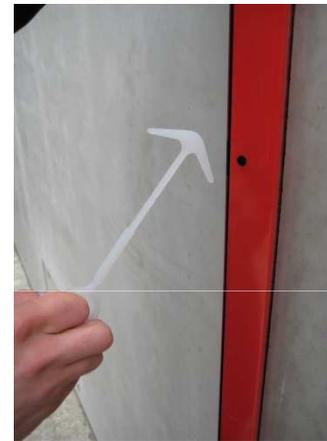
2.) Einführen des Ruck-Zuck Ankers durch die Öffnung der Ruck-Zuck Schiene
